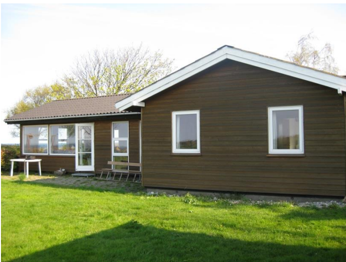
Hus mod syd. Huset har nye vinduer og beklædning fra 2009
